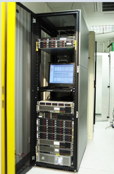
Dank Caching-Server können die Ärzte standortunabhängig arbeiten; das zentral gepflegte Sprachprofil sorgt für konstant hohe Erkennungsraten.
